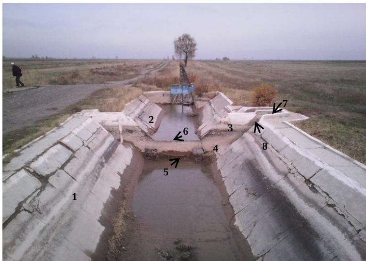
Рис. 1. Типовое водомерное сооружение с трапецидальным водосливом ВБЧК. 1 – подводящий участок водотока; 2 – отводящий участок водотока; 3 – измерительный створ; 4 – диафрагма; 5 – наноспромывные отверстия; 6 – водослив с тонкой стенкой; 7 – водомерная рейка; 8 – береговой ковш
